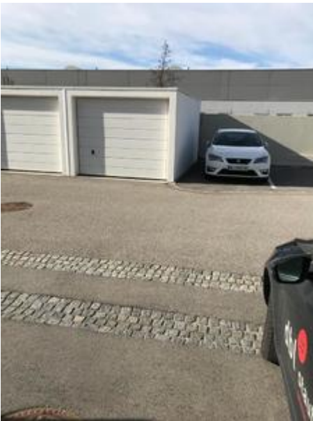
Garage mit Stellplätzen Doppelhaushälfte Gunkirchen
